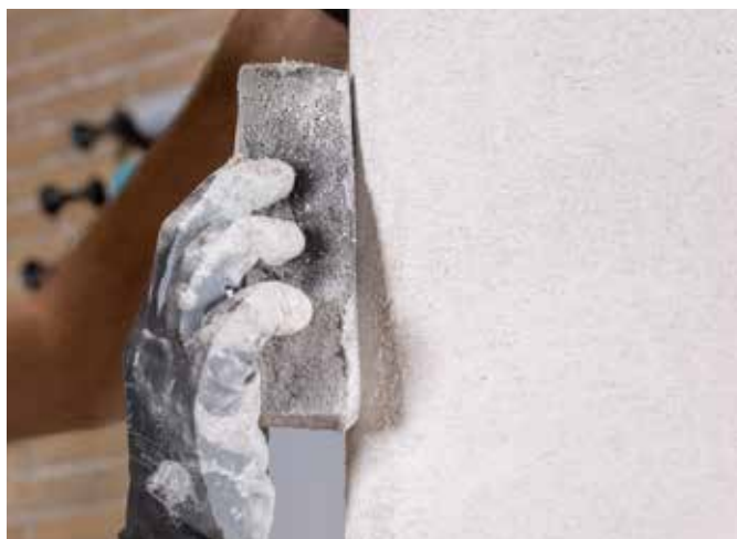
3. Putsa de externa ytorna. Försäkra dig om att alla kanter är jämna och låt det sedan torka.
