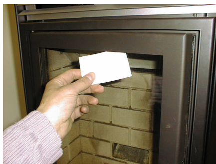
Bild 5 Renöring av luftspalt
