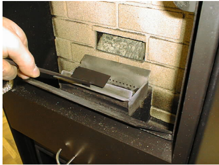
Bild 1 Urtagning av brännkoppen
