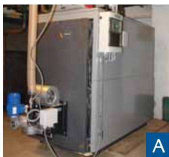
Bilden visar en gammal oljepanna som är konverterad med två st 100kW pelletsbrännare. En sådan investering är oftast betald på mindre än två år.
