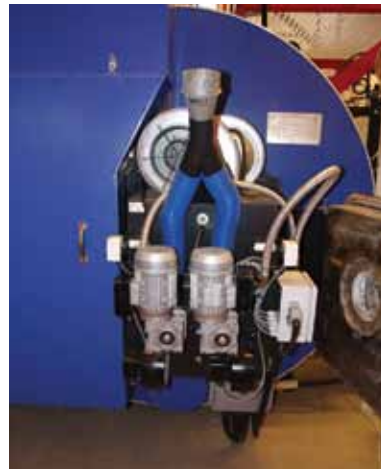
Östersund, 700kW pelletsbrännare
