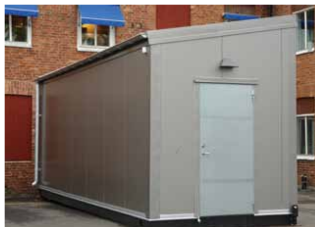
Värmemodul 500 - 700 kW
