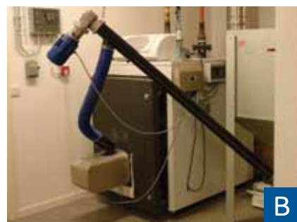
Bilden visar en gammal oljepanna som är konverterad med två st 100kW pelletsbrännare. En sådan investering är oftast betald på mindre än två år.
