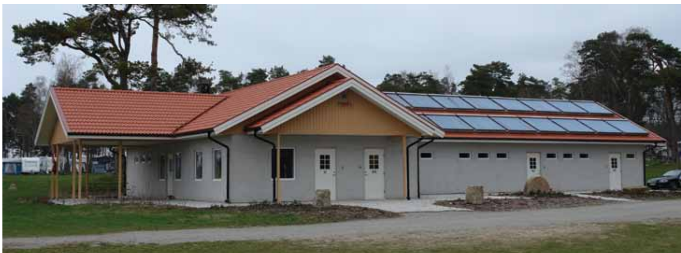
Götene, 50 kW pelletsanläggning samt 16 st vakuumsolfångare
