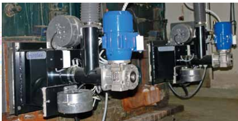
Bilden visar en gammal oljepanna som är konverterad med två st 100kW pelletsbrännare. En sådan investering är oftast betald på mindre än två år.
