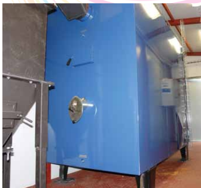
Samtliga pannor har synglas på baksidan, man kan då se lågan från rätt håll!
